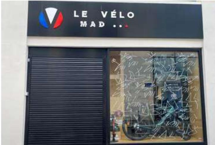
Le rideau métallique de sécurité MiniMax est la solution idéale pour sécuriser les locaux professionnels, collectifs, tertiaires et d'habitation en toute discrétion et avec beaucoup de facilité. Certifié A2P R2\*, il est doté de lames en acier et d'un dispositif de verrouillage automatique à la fermeture.
